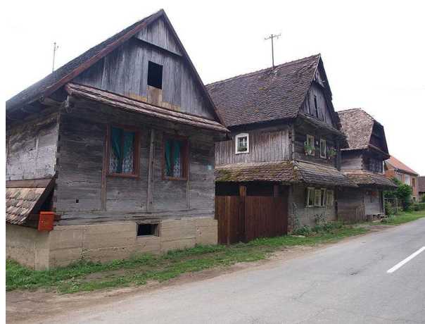
Rysunek 1 Tradycyjne drewniane chaty we wsi Krapje na terenach zalewowych w Lonjsko Polje w Chorwacji. Najstarsze z nich, ok. 200-letnie, budowano na drewnianych palach lub kamiennych słupkach, które później wykonywano z cegły, Fot. Frka
