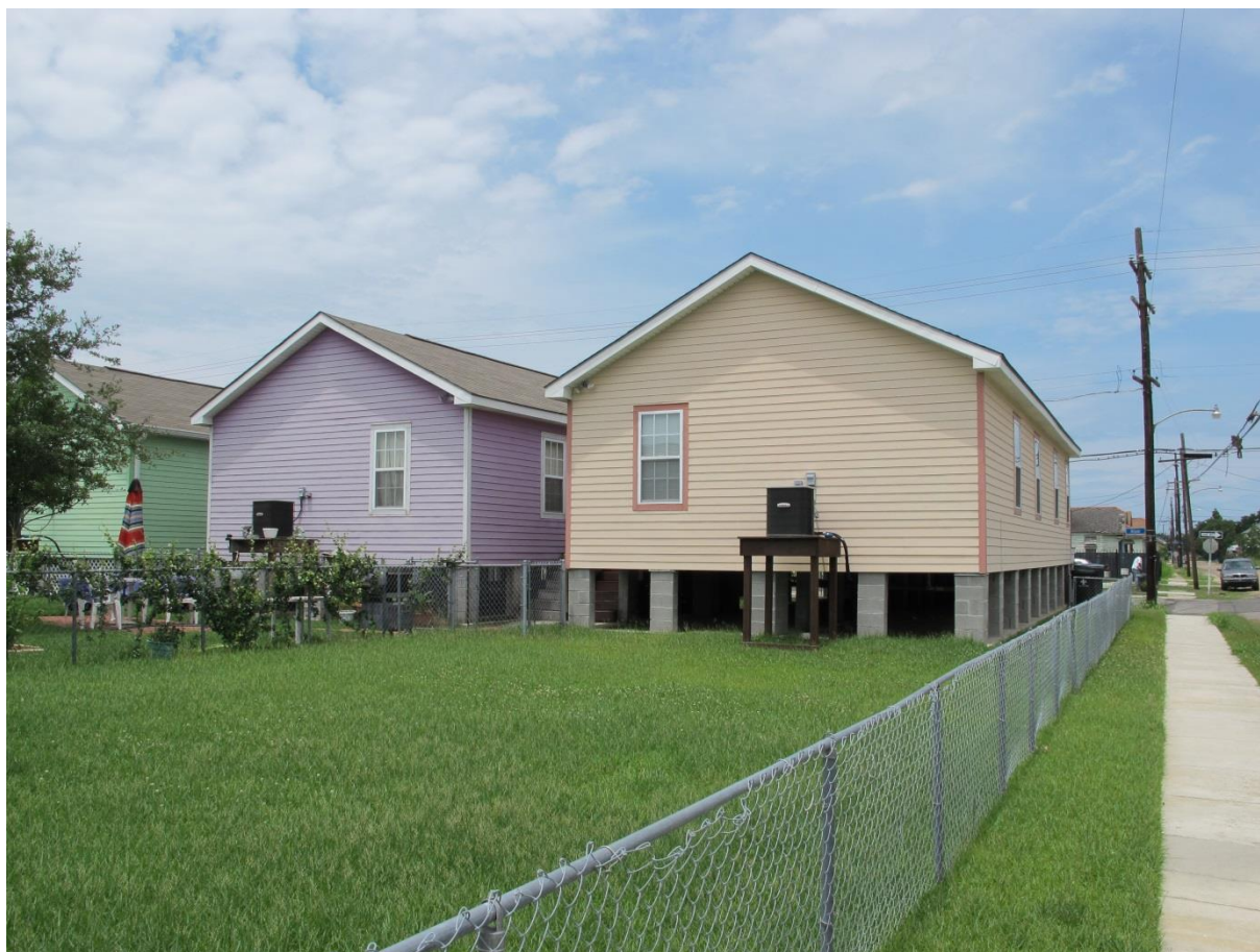
Rysunek 12 Domy o podniesionym poziomie parteru (powyżej lustra wody powodziowej), o konstrukcji pozwalającej na swobodny przepływ wody w czasie powodzi, Nowy Orlean, po huraganie Katrina. Fot. M. Arczyńska.
