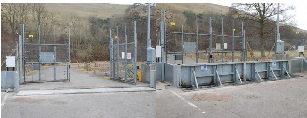
Rysunek 11 Podnoszona bariera, ukryta pod ziemią lub przymocowana do linearnej konstrukcji bariera aktywowana automatycznie lub ręcznie - mechanizm otwierania opiera się na systemie sprężyn, źródło: Aquobex.com
